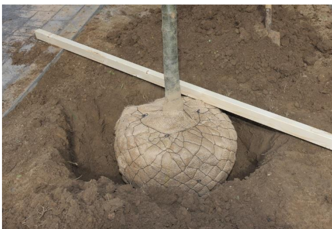
Abbildung 1: Der Baum sollte in der vorbereiteten Pflanzgrube etwas höher eingepflanzt werden (5-10 cm), Bildquelle: LKSH
